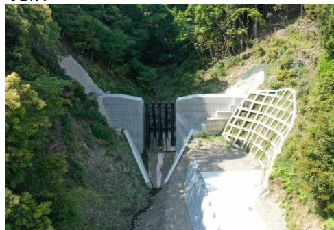
半沿川砂防堰堤
