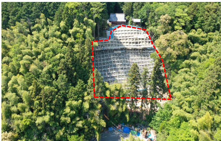
寺垣内5地区急傾斜地崩壊対策事業（紀の川市桃山町黒川）
