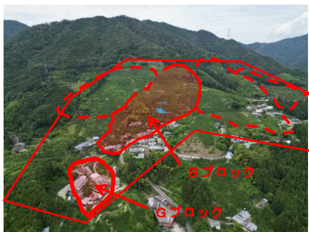
下鞆渚地区地すべりブロック全景
