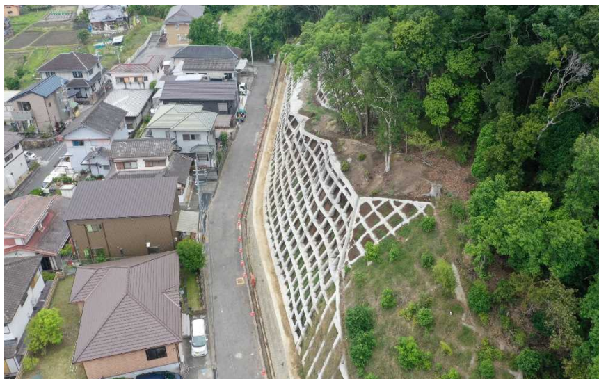
山地区急傾斜地崩壊対策事業（岩出市山）
