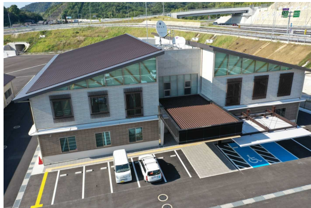
【海草振興局建設部 庁舎玄関前】
