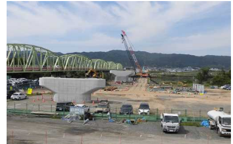
【写真 仮称新南田井ノ瀬橋下部工 (和歌山市出島)】
