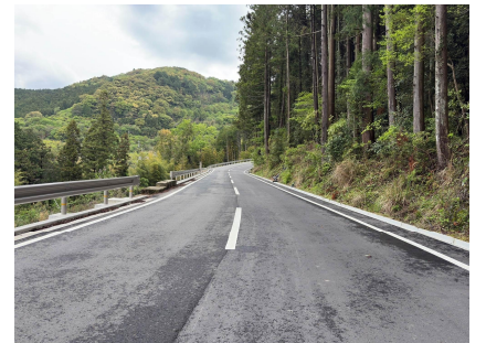
【写真 国道424号(海南市上谷)】
