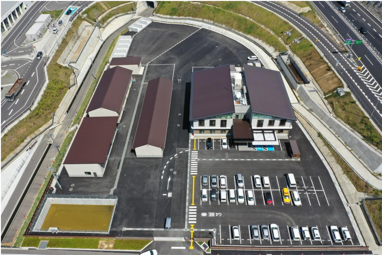
(写真 庁舎上空より撮影)
