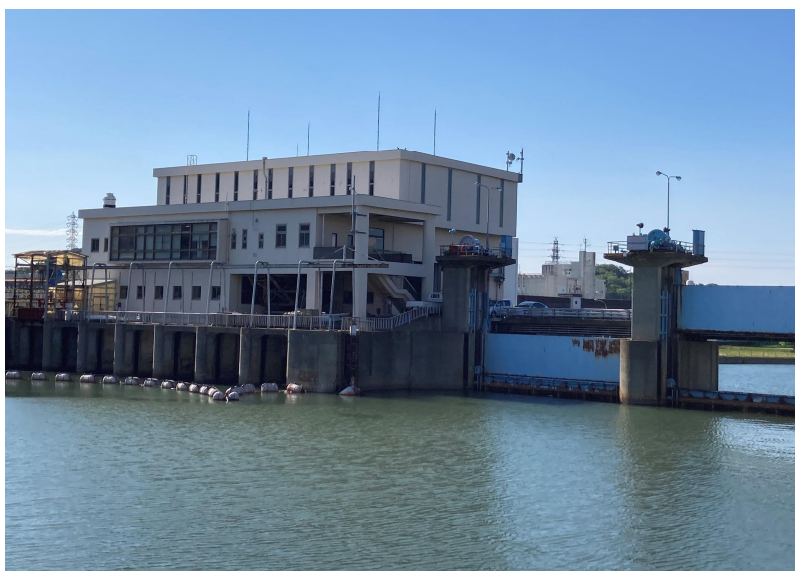
水防や水質改善を担う和歌川ポンプ場
