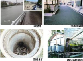
雨水貯留浸透施設の例
