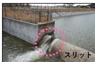
▲スリットの設置状況
