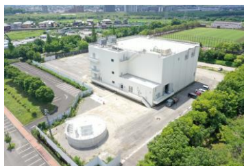
雨水ポンプ場
