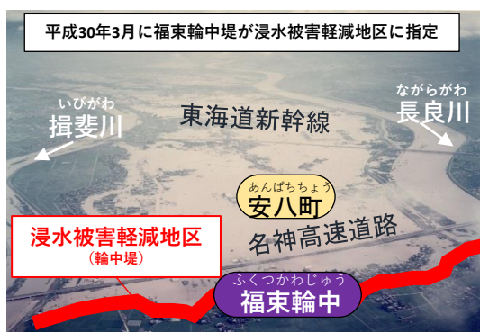
福束輪中堤(昭和51年9月 台風17号浸水時)
