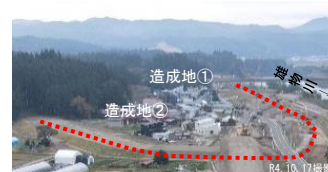
移転家屋の建設が進む状況
