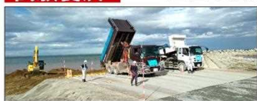
養浜材の荷下・投入状況 (R4.8.18 撮影)
