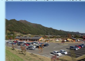
交流施設の整備 (ハツ場ダム)
