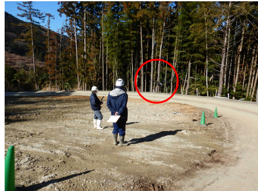
出来形計測（空中写真測量）
