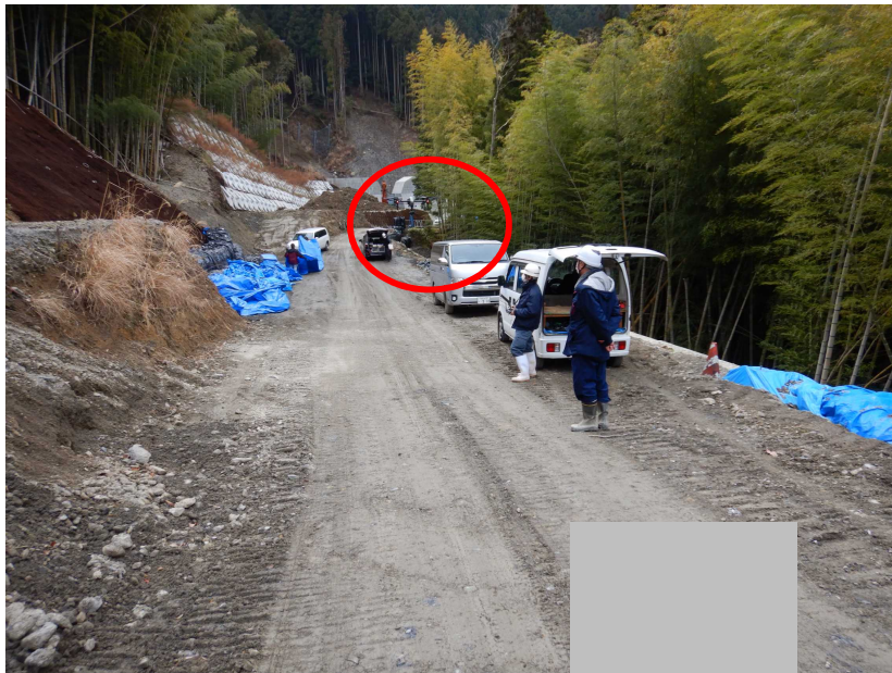
起工測量（空中写真測量）
