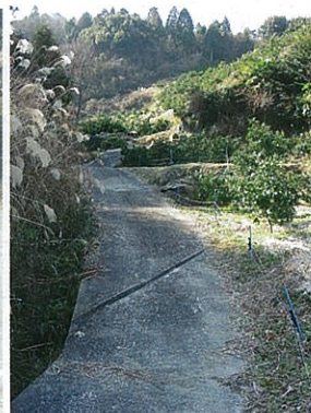
園内道の排水性を考慮して溝を設置されています
