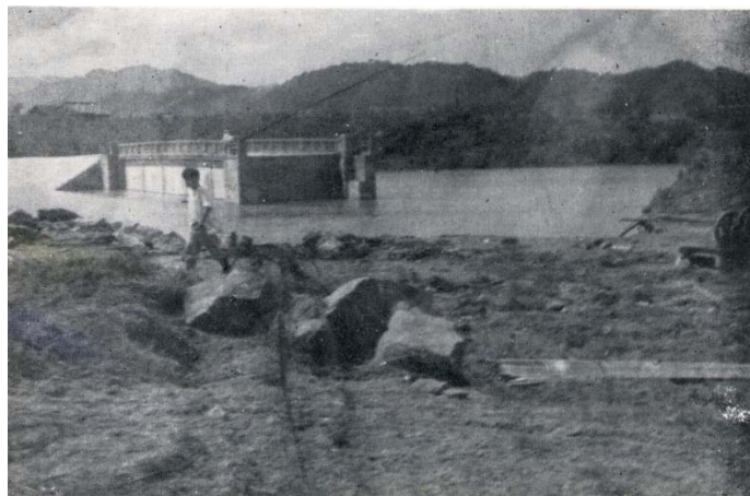
一般国道の流失（熊野市志原地内）
