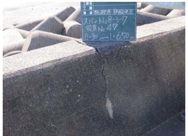
変状：ひび割れ(鵜殿港鵜殿地区)
