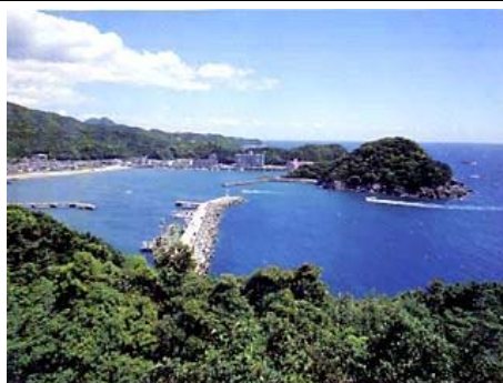
防波堤(すさみ町)
