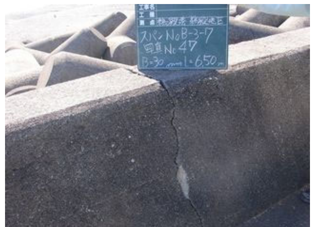
変状：ひび割れ(鵜殿港鵜殿地区)
