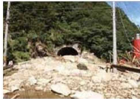
国道168号（新宮市）
