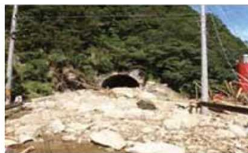
国道 168 号（新宮市）
