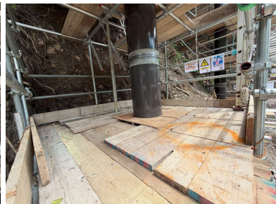
全面足場板設置状況
