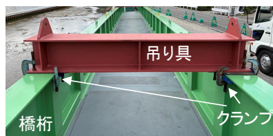
橋桁と吊り具をクランプで固定した状態
