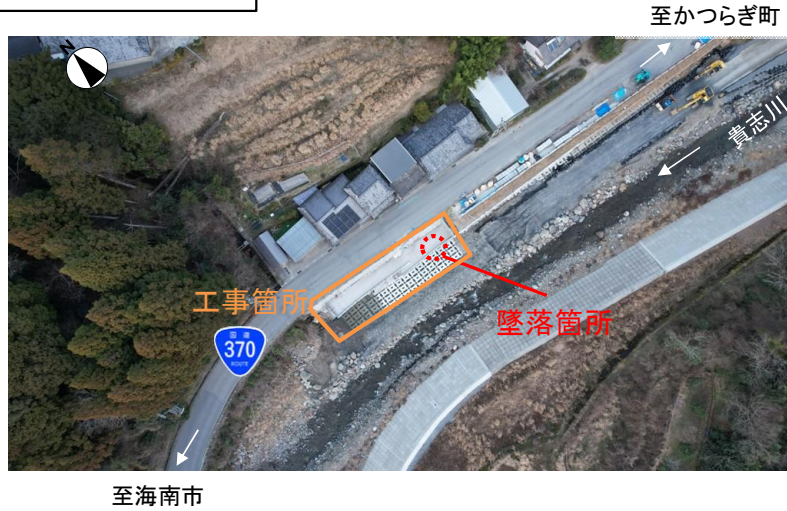
墜落箇所 航空写真
