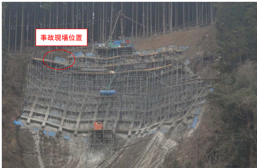
【 作業箇所全景 】
