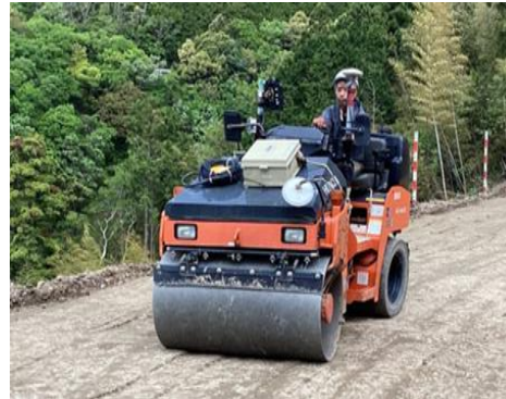
GNSS受信機を搭載したローラー車による転圧状況とガイドモニター
