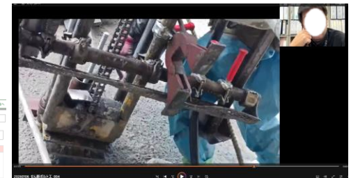
グラウト注入確認
