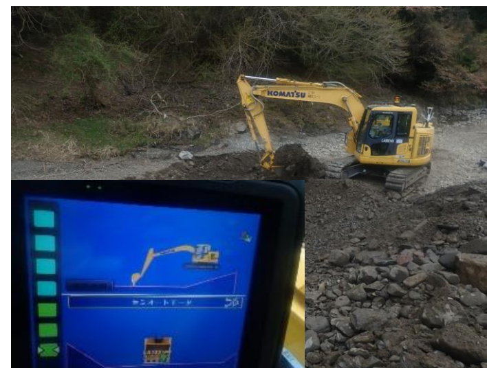
○ ICT機器による現場施工
