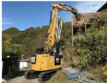
(解体用掴み機) ・・・がれき等の除去
