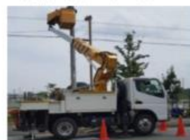
(高所作業) ・・・電線の復旧時に使用
