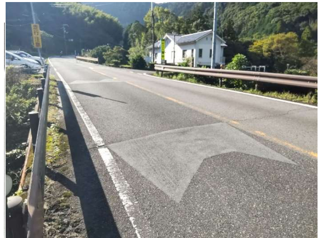
すりつけ補修後 2 年経過写真
