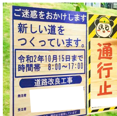
紀州材の工事看板 (県産品)
