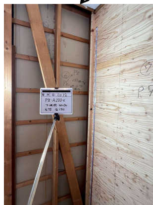
既存筋かいの確認
