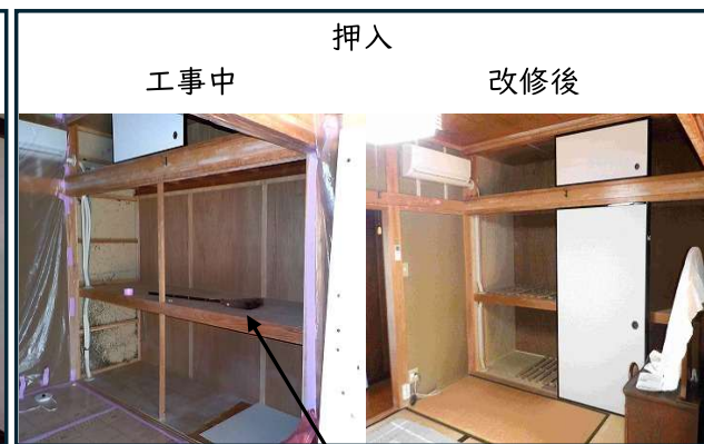
棚板をそのまま施工することで工期短縮
