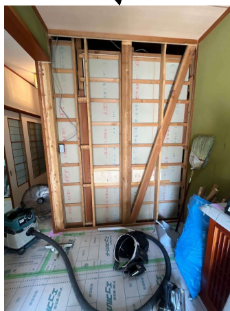
既存筋かいの確認
