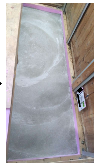
コンクリート打設
