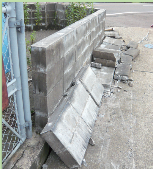
たて筋がなく、上2段が滑り落ちたと推測される。
