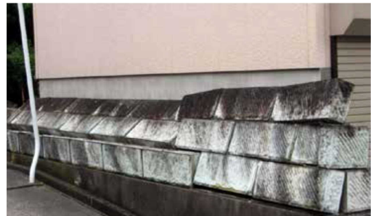
出典 (一財) 消防科学総合センター
