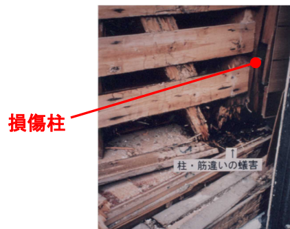
出典 被災建築物応急危険度判定マニュアル
