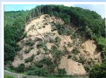
発生した地すべりにより斜面下部の川がせき止められています
