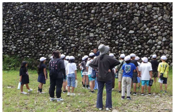
防災学習(鳴子谷川砂防えん堤)
