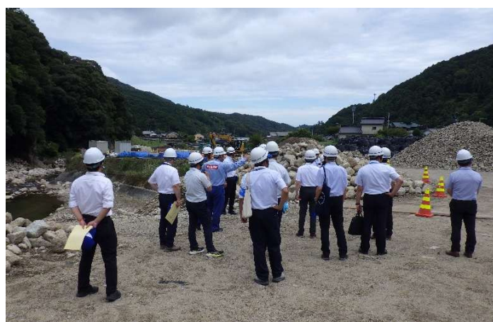
現地見学(工事状況)
