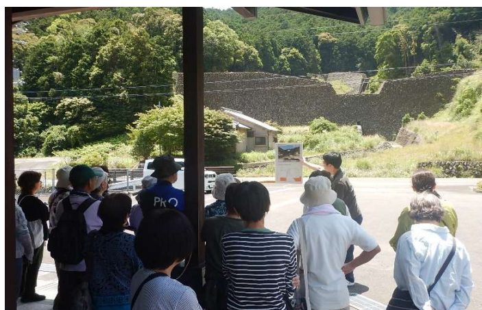
防災研修(鳴子谷川えん堤説明)
