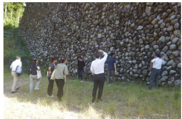
鳴子谷川砂防えん堤見学
