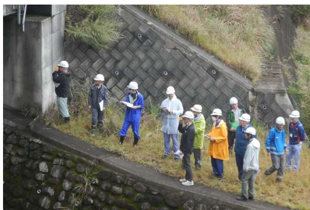
水路断面を計測する様子
