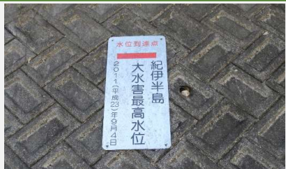
紀伊半島大水害最高水位 日高川町小釜本
