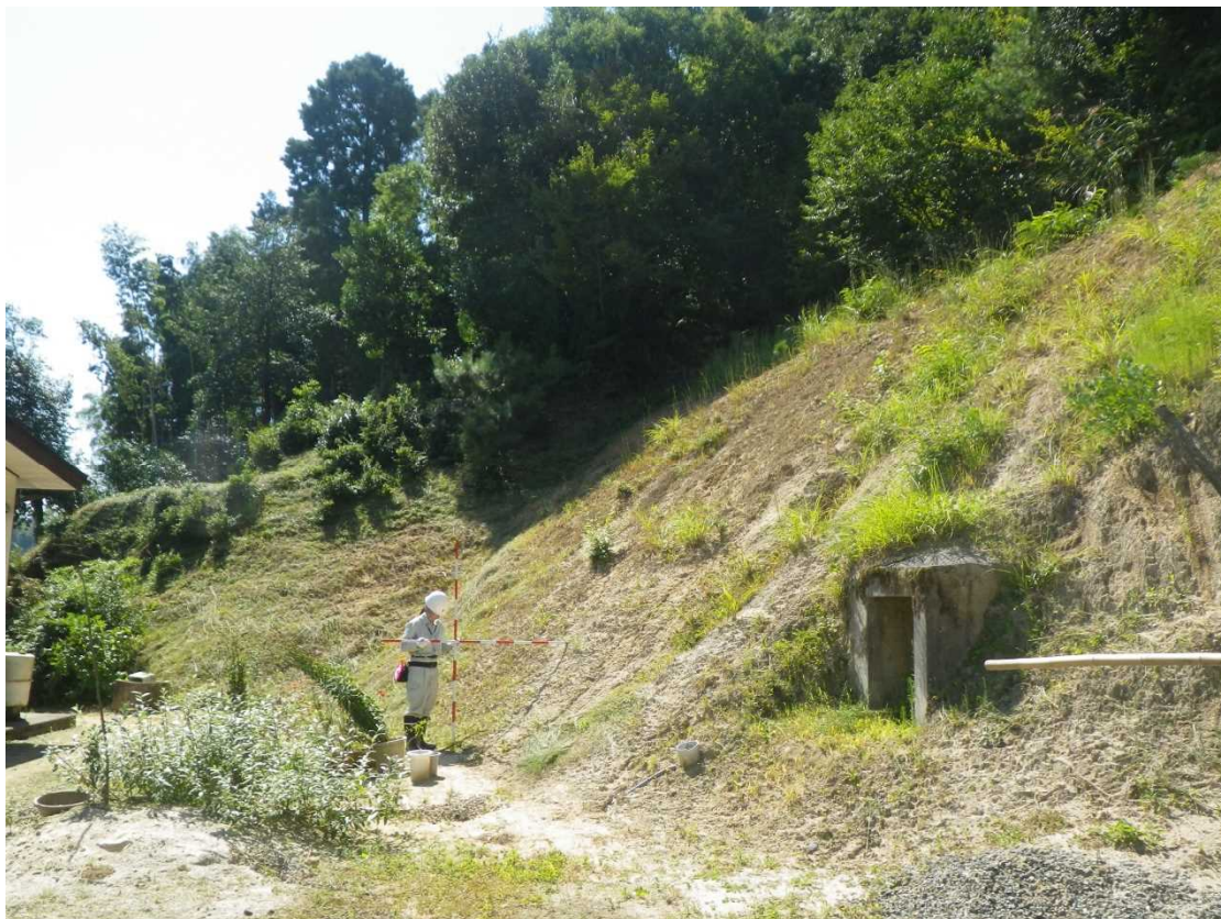
図Ⅱ- 3.5 下端位置確認状況(施設無)
