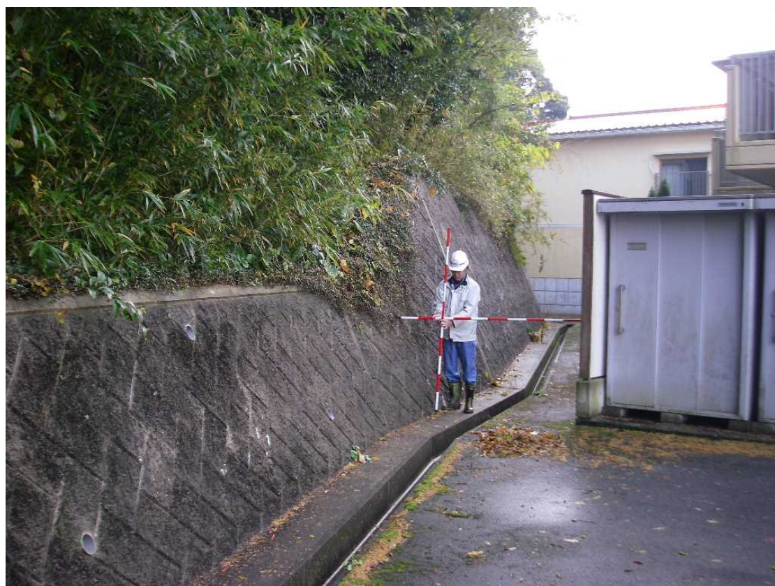
図Ⅱ- 3.6 下端位置確認状況(施設有)
