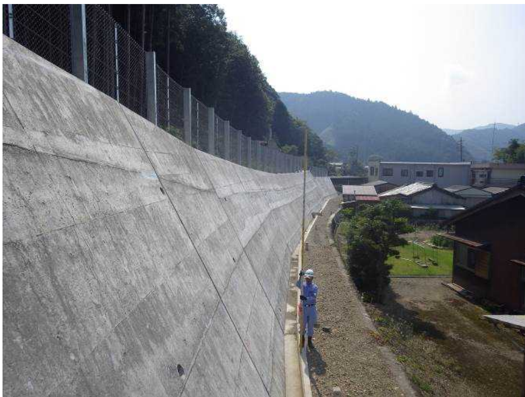
図Ⅱ- 3.14 対策施設全体写真例
