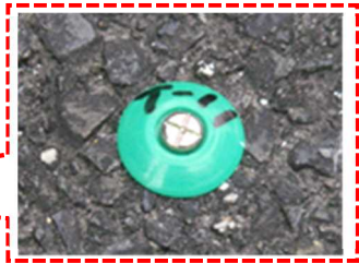
図 II - 3.9 現地での引照点の設置状況例
