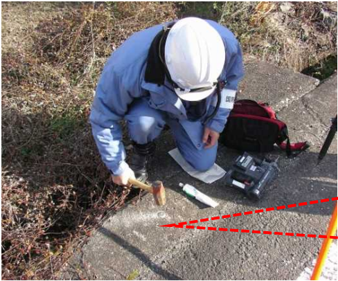
引照点(鋳)の設置
