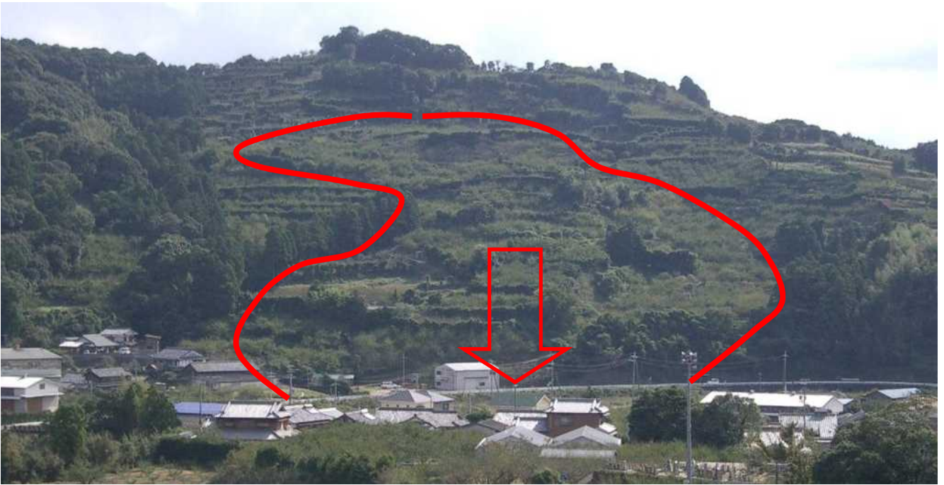
図IV- 3.3 地すべりブロック状況
