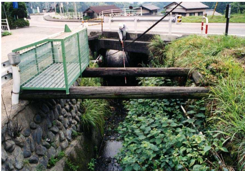
図Ⅲ- 3.4 土石流の流れに影響を与える人工構造物の例
