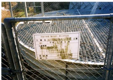
図IV- 3.9 対策施設状況(集水井工)
