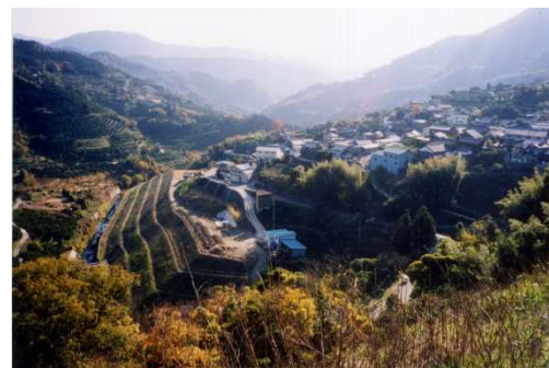
図IV- 3.10 対策施設状況(押さえ盛土工)
