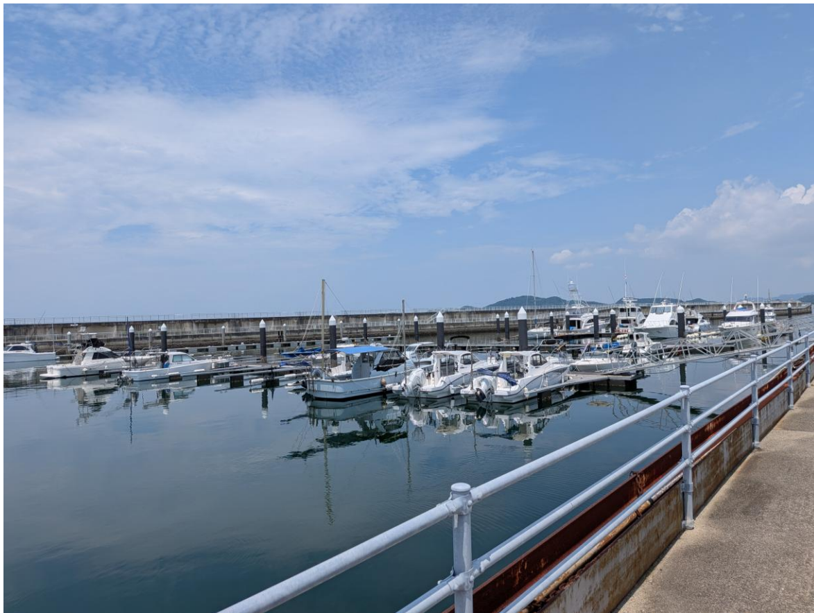
水面係留施設
