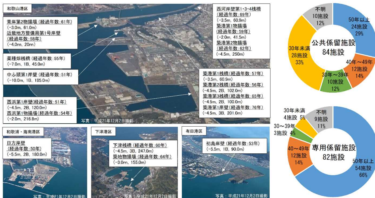
図 3.43 係留施設の老朽化状況
