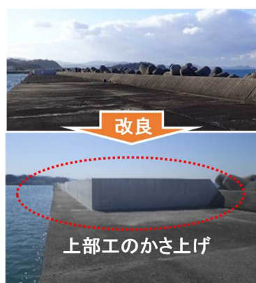
図 3.39 和歌山港区の 防波堤の粘り強い化
