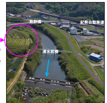
【流下能力不足箇所：熊野橋下流付近】
