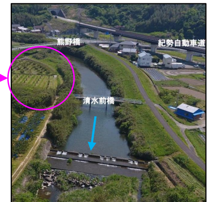
【流下能力不足箇所: 熊野橋下流付近】
