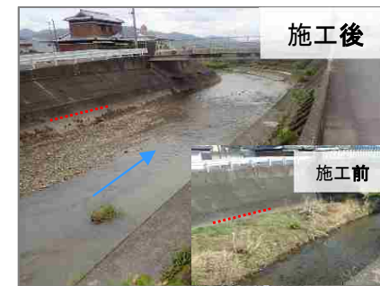
【志賀川 河道掘削 谷口橋付近】
