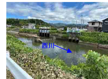
【西川 東裏川合流部】
