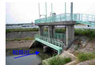
【和田川 西川合流部】
