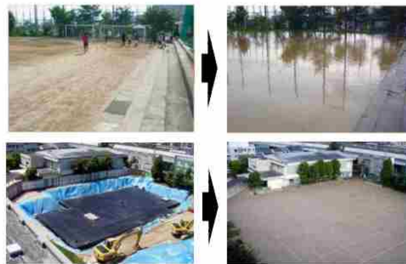
【雨水貯留浸透施設】
