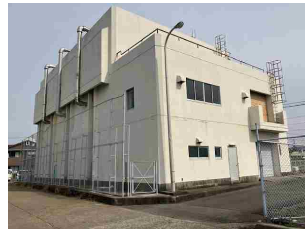
【上川ポンプ場】
