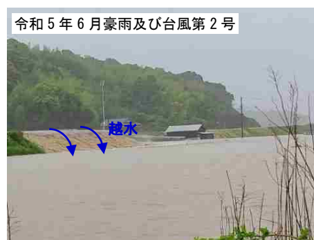
西川（越水の様子）志賀川合流部下流
