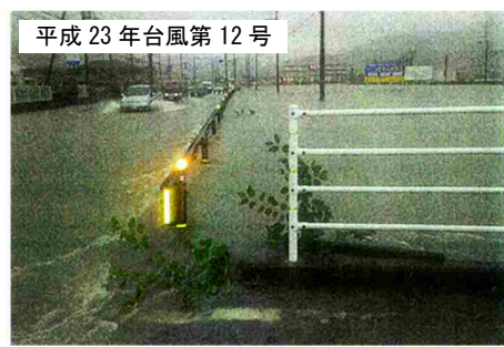
荊木地区（国道42号）
