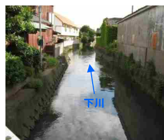
写真 1 - 3 下川 巽橋付近 下川1.1k付近
