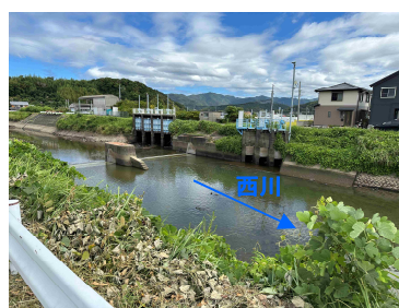
写真 1 - 2 東裏川千貫樋門 西川3.3k付近
