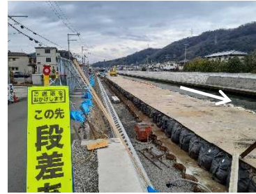
②築堤護岸(整備中)
