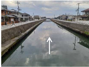
①築堤護岸(整備済)
