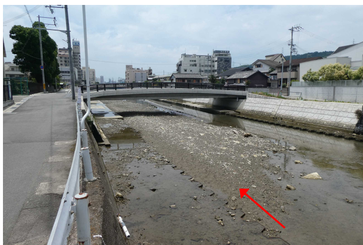
図 4－5 0.9k 付近（下橋付近を望む）
