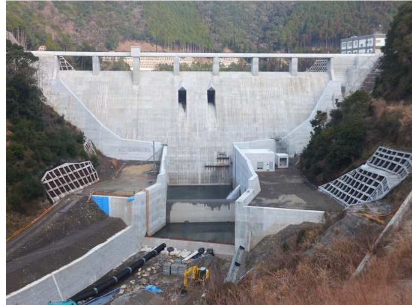
平成27年 1月 (堤内仮排水路部施工中)
