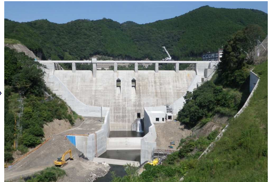
平成26年 9月 (堤頂部施工中)
