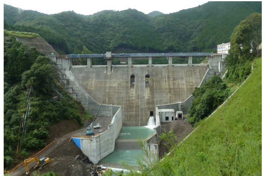
平成26年 8月 (堤頂部施工中)
