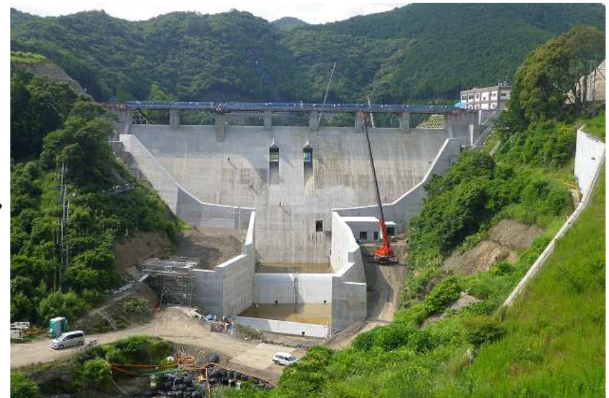
平成26年 6月 (堤頂部施工中)
