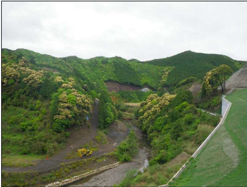
平成24年 5月 (ダムサイト伐採開始)
