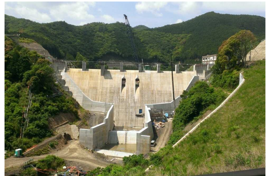
平成26年 5月 (堤頂部施工中)
