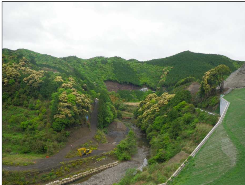
平成24年 5月 (ダムサイト伐採開始)
