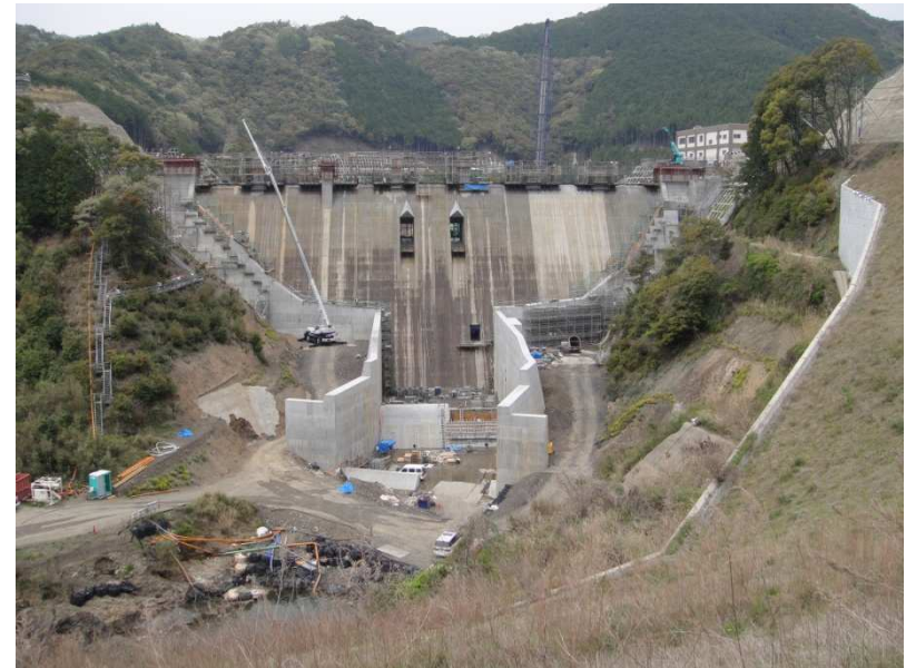
平成26年 4月 (本体コンクリート打設中)
