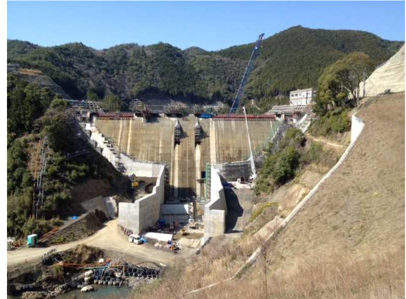
平成26年3月 (本体コンクリート打設中)
