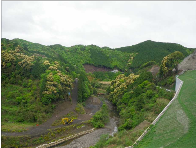
平成24年 5月 (ダムサイト伐採開始)
