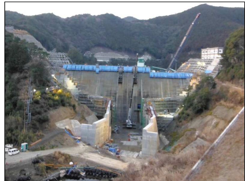
平成26年2月 (本体コンクリート打設中)
