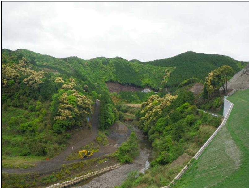
平成24年 5月 (ダムサイト伐採開始)
