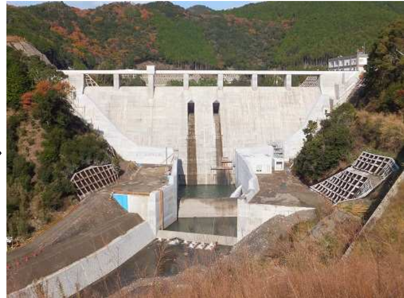
平成26年 12月 (堤内仮排水路部施工中)
